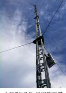
令和5年9月 風況観測塔
